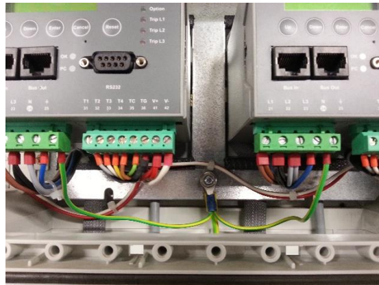
Figuur 2. Aardplaat ten behoeve van besturingsmodule
