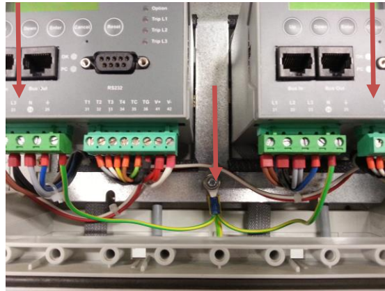
Figuur 2. Aardplaat ten behoeve van besturingsmodule.
